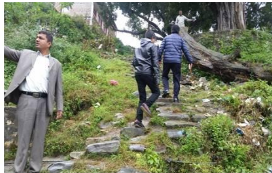
पाँचौं गणेश कालिका मन्दिर जाने बाटोको सिढी पुनः निर्माण
